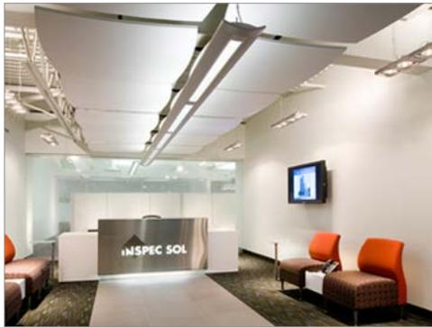
Alliant des lignes épurées et une esthétique arrondie, le luminaire **LT SurroundLite** met en avant efficacité supérieure, contrôle de l'éblouissement et options multiples, en vue d'éclairer des locaux de grande et de moyenne dimension. L'appareil présente une optique SurroundLite qui assure une luminosité équilibrée en dirigeant de larges pans lumineux dans tous les sens.
