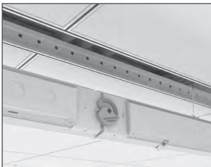
Connexions mécaniques, électriques et de commande d'éclairage très commodes d'un luminaire à l'autre. Processus simplifié grâce au InstaJoiner, en instance de brevet.
